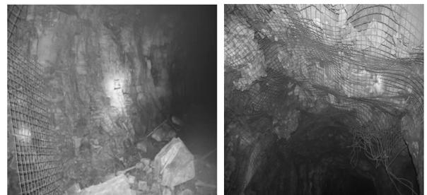
图11 出矿巷道围岩支护及其破坏
