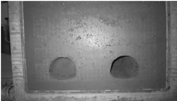
图5 隧道开挖完成
