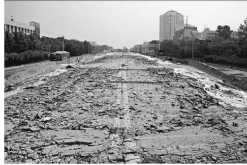
图 13 水压爆破箱梁的桥面效果
