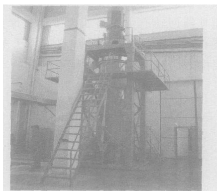
图5 大型超细搅拌磨机在亚微米级重质碳酸钙生产现场应用
