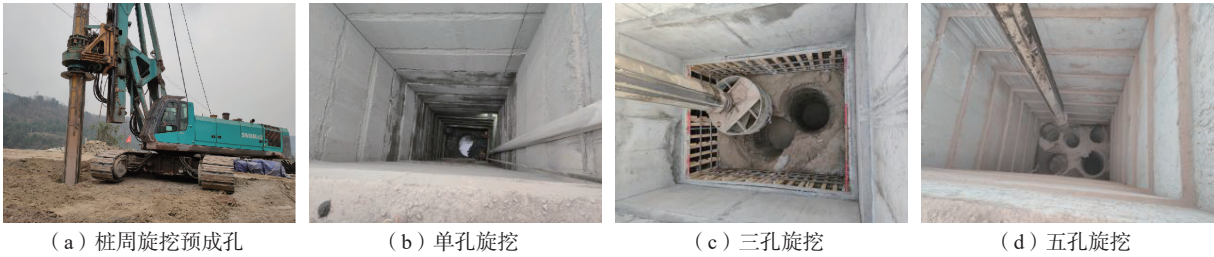
图 5 “桩周旋挖引孔开挖回填+桩芯旋挖取土+人工辅助清边”实况图
