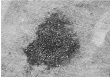
图2 混凝土表层黑斑
