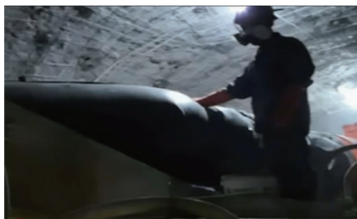
(d) 除尘设备安装
