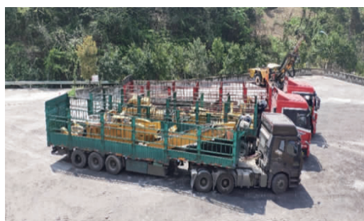
(a) 设备进场及吊装
