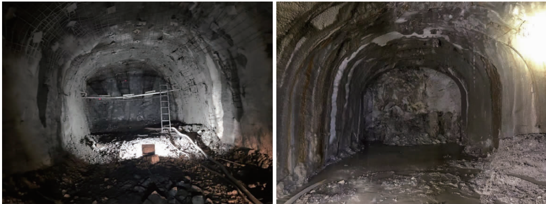
图 1 凿岩爆破掘进巷道现场图
