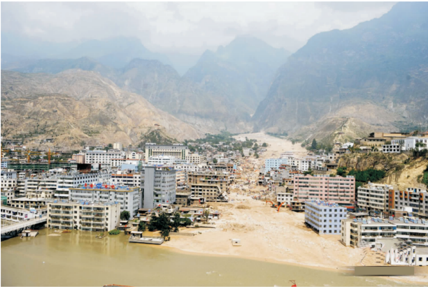
图 3 舟曲泥石流沟口堆积物堵塞白龙江
