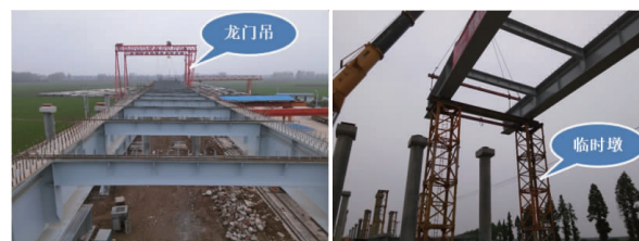
(a) 通过龙门吊安装钢梁
