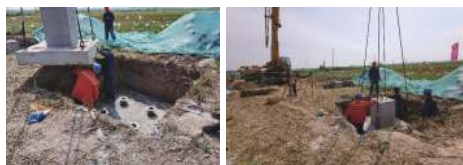
图 21 工程现场钢管桩施工照片
