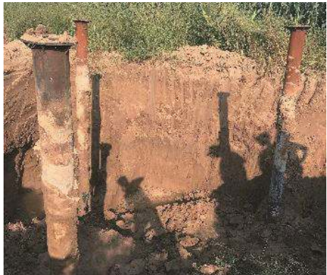
图 12 现场开挖出的裸露的钢管桩
