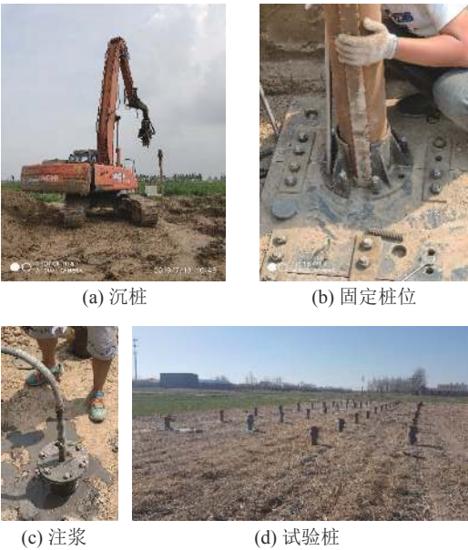
图 4 试验桩现场施工
