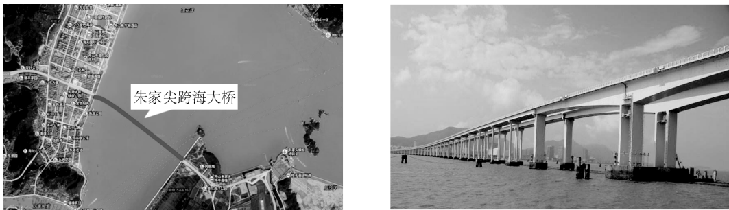
图 2 朱家尖跨海大桥桥位图 Fig. 2 Bridge map of the Zhujiajian Sea-Crossing Bridge
