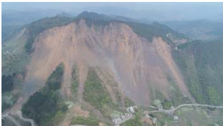
图 2 马路组崩塌全貌
