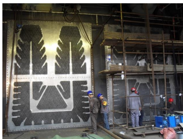
图 3 (网络版彩色)莱城发电厂 2 号机组凝汽器改造现场
